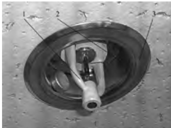
1 – пиротехнический привод; 2 – ороситель; 3 – декоративная чашка
