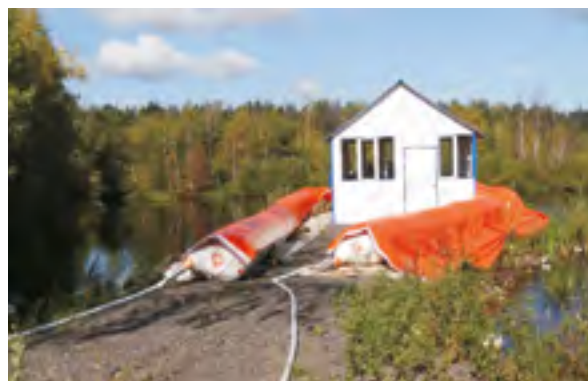
Водоналивная мягкая мобильная дамба
